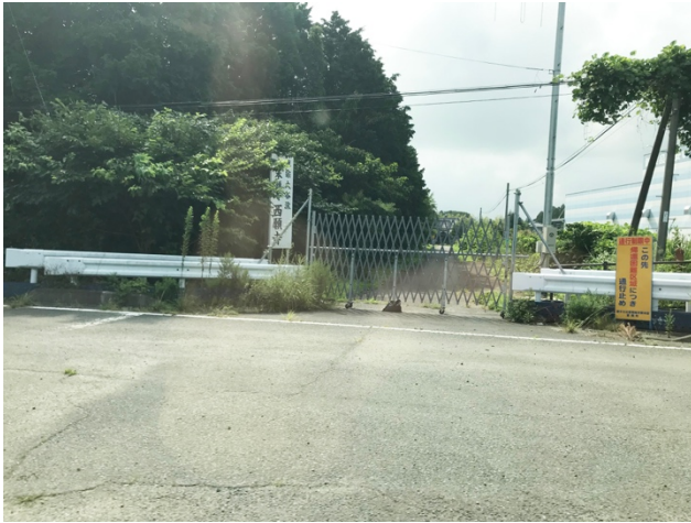
バリケードや、通行止め区域あり。
