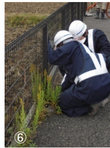
④⑤高圧洗浄機を使って除染中。 ⑥駐車場の端は草をむしったり、ホウキで掃いて線量が高い砂を取り除いていきます。
